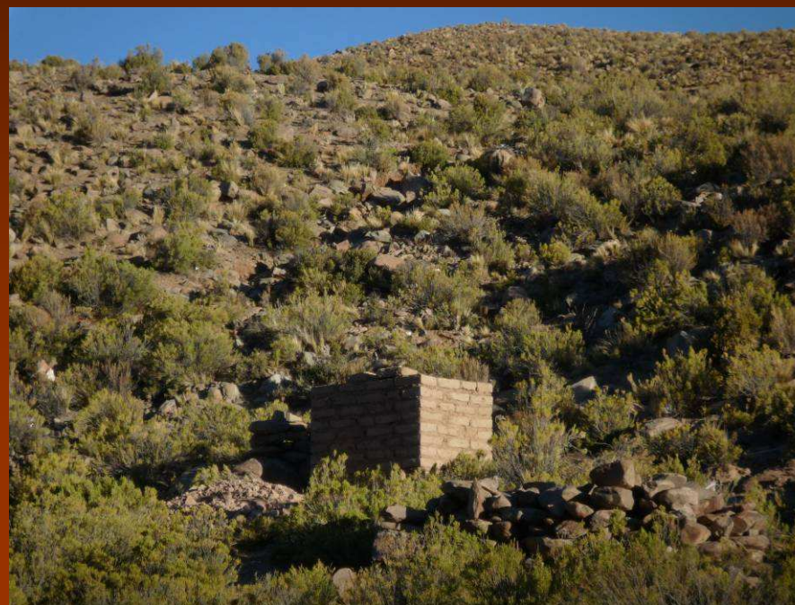
Cisterna en San Juan y Oros
