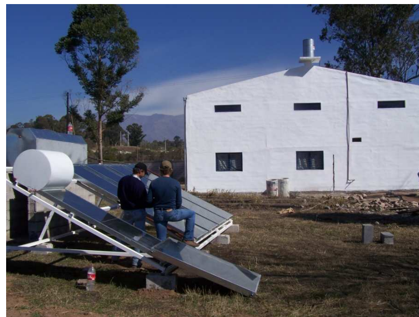
Ing. Realizando mediciones a un colector para hotel
