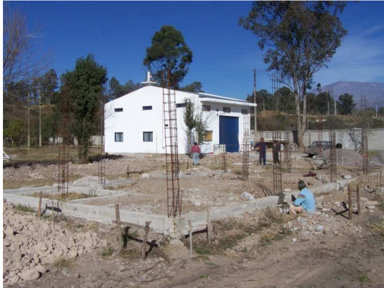
Obra en construcción
